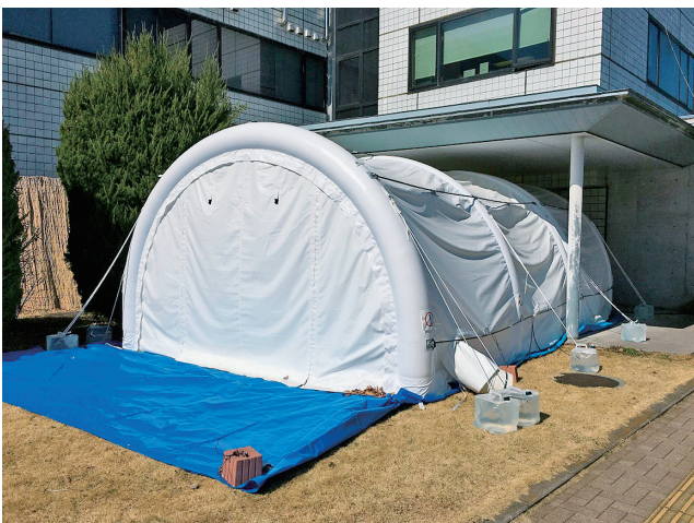
陰圧式エアートント設置(2月)
