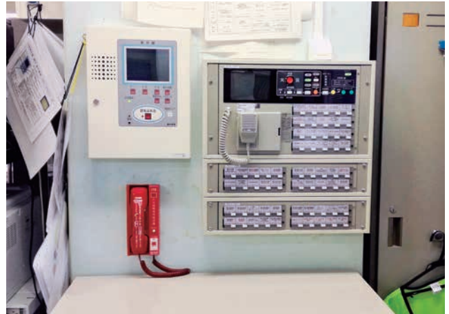
非常用放送設備アンプ更新 (2 月)
